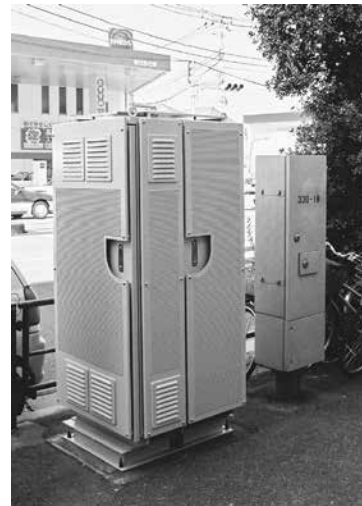
写真4 交通信号機非常用燃料電池システム
