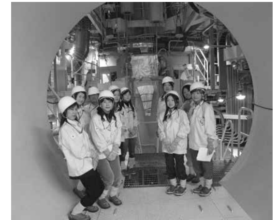
写真3 格納容器出入口にて
