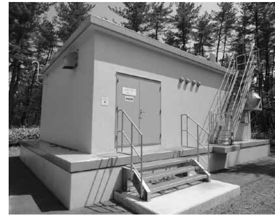
写真3 定置型モニタリングポスト（免震局舎）の外観
