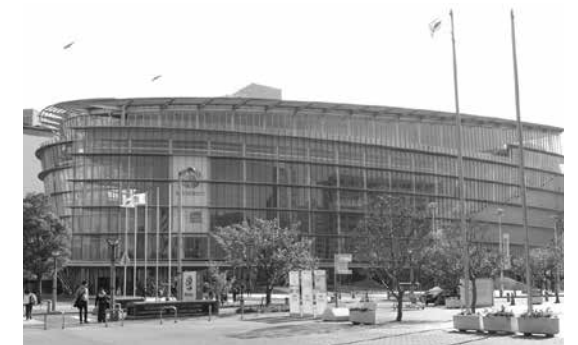
写真1 日本科学未来館の外観
