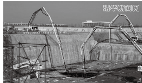
図8 HTR-PMコンクリート打設開始時の状況（2012年12月） 6)
