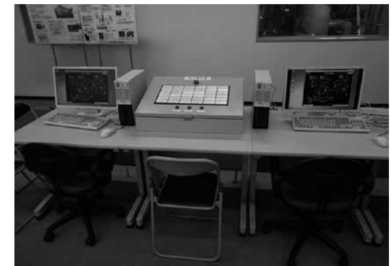
写真7 計測制御コンソール
