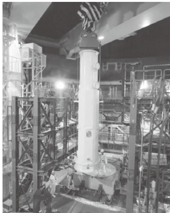
写真11 試料部回収装置の移動 （試料部などを収容した状態）
