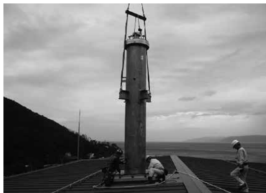
写真4 縦型タンク搬入工事
