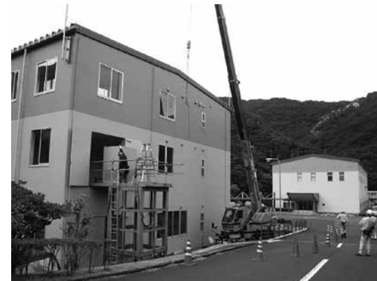
写真5 電気盤搬入工事
